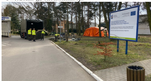
Budowa tymczasowej przyszpitalnej izby przyjęć
