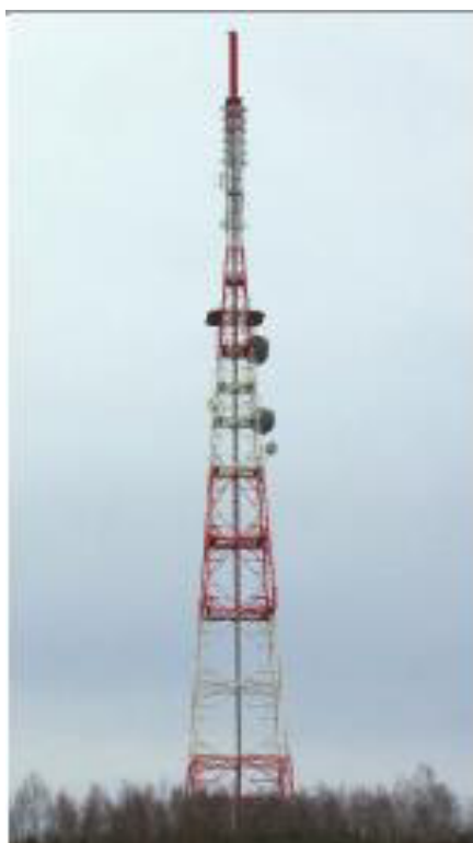
Fot. 1. RTCN Gniezno Chojna – widok obiektu
