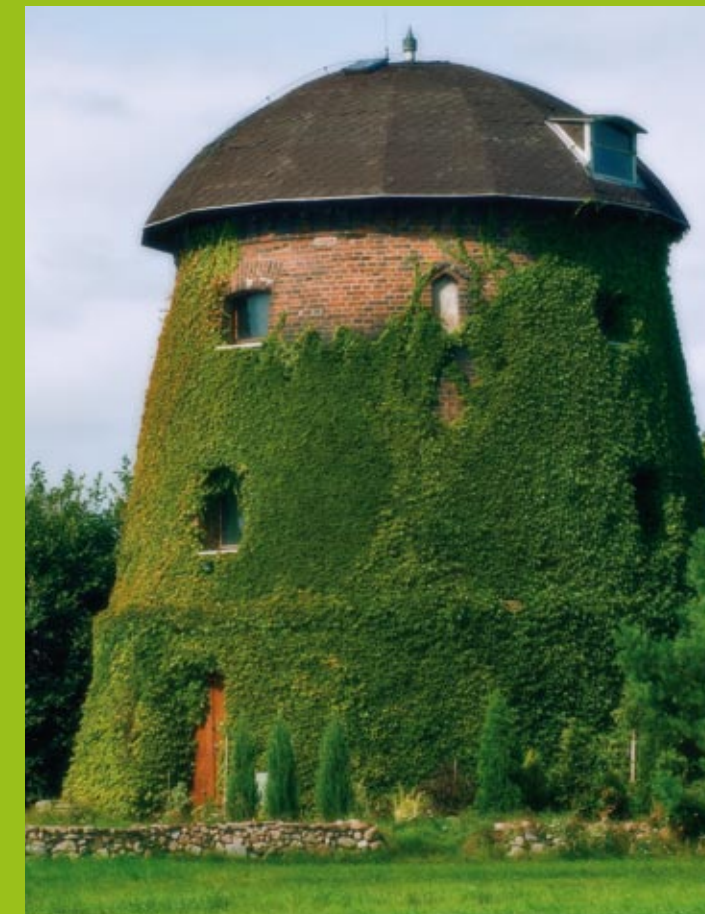
Wiatrak typu holenderskiego w Bracholinie z 2 połowy XIX w., murowany z cegły na wysokiej podmurówce kamiennej. Cechuje go drewniana kopulasta głowica kryta papą.
