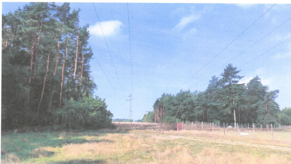
Zdjęcie nr 2. . Linia 110 kV Rogoźno - Wągrowiec, przęsło 33-34.
