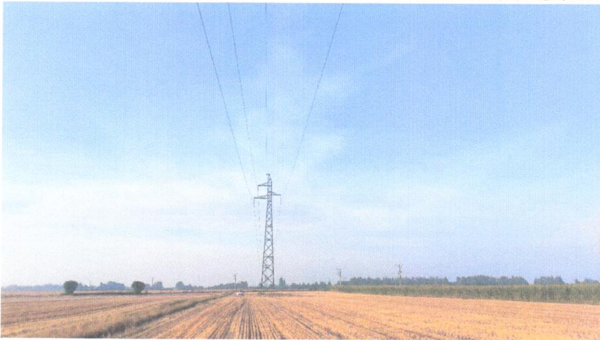
Zdjęcie nr 1. Linia 110 kV Rogoźno - Wągrowiec, przęsło 5-6.
