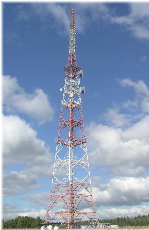
Fot. 1. RTCN Gniezno / Chojna – widok wieży antenowej
